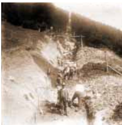
1902: construction du funi
